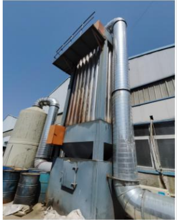
电焦油捕捉器
