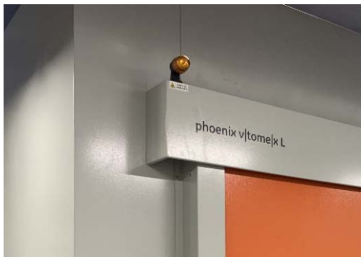
铅房外警示灯
