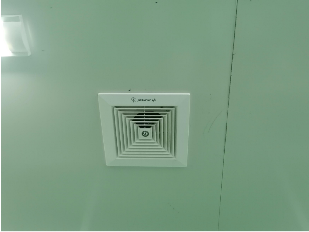
图 4-2 机械排风装置
