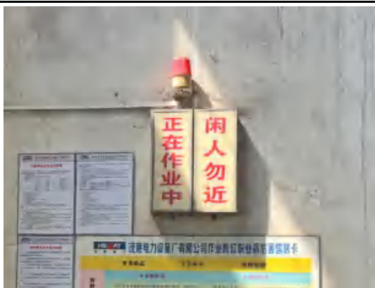
图 3-3.3 声光报警装置
