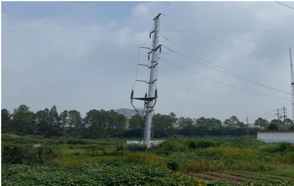
图 8-2 架空线路、塔基周边环境绿化恢复情况
