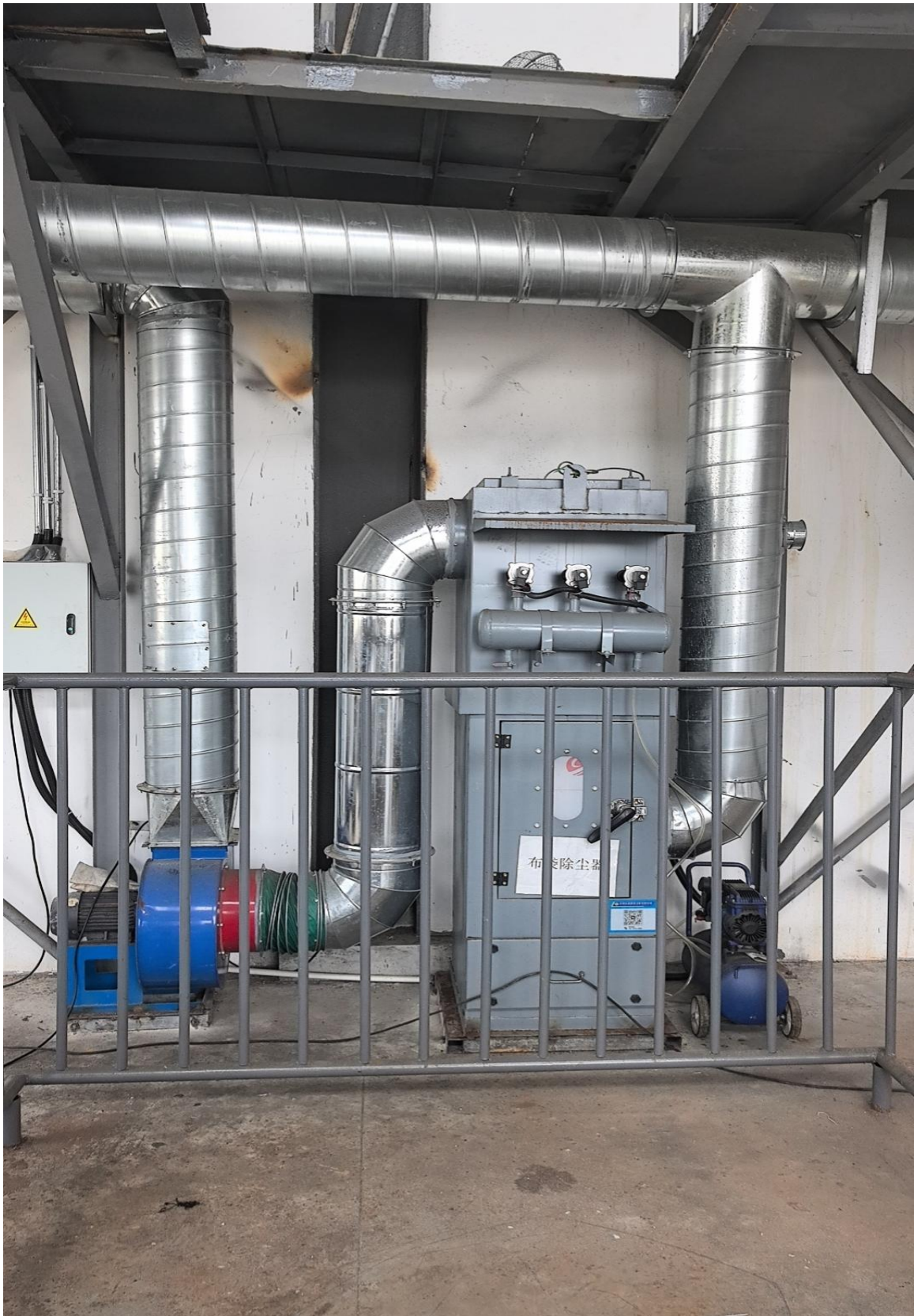
图4.1-2 粉尘收集处理装置
